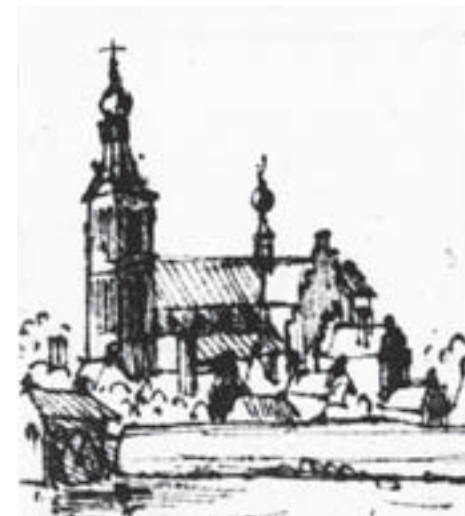
De Sint Lambertuskerk werd in de periode van 1856 tot 1861 gerestaureerd, daarbij werd het gebouw bijna geheel vernieuwd. De toren kreeg een nieuwe mantel en de spits werd verhoogd. Door deze verbouwing is het authentieke karakter van de kerk verloren gegaan. De toren telt tegenwoordig vijf vloeren. Het uurwerk en de speeltrommel staan op de vierde laag, de vijfde bevat het stokkenklavier en de speelkamer. (tekenaar onbekend, collectie RHCE)
