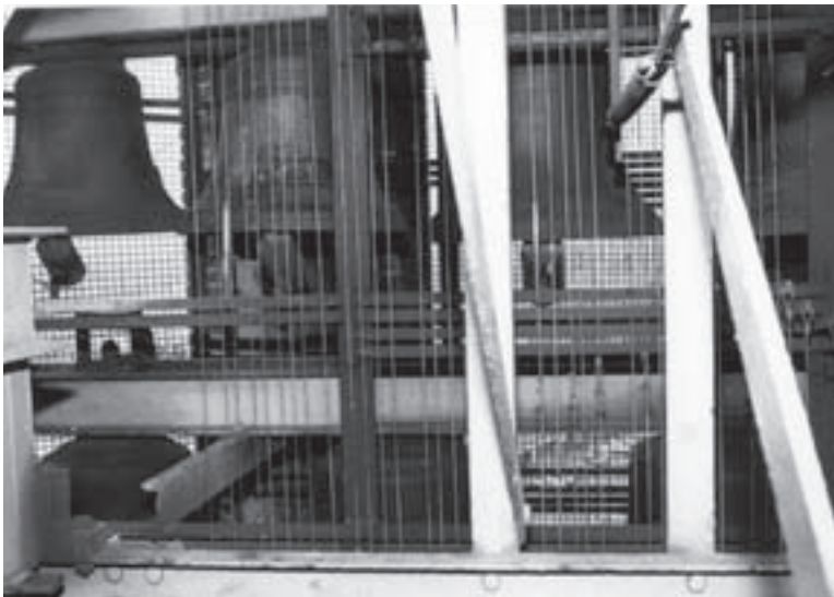
De bedrading voor het bedienen van het carillon met daarachter de klokken. (fotograaf L. van der Zanden, collectie RHCe)
